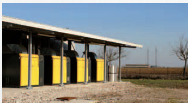
L'impianto di compressione per aria a bassa pressione Kaeser.
