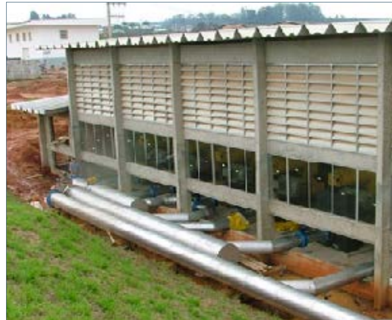
La figura in alto mostra un collettore di grandi dimensioni dotato di isolamento per ridurre lo scambio termico con l'aria di raffreddamento dell'unità.
