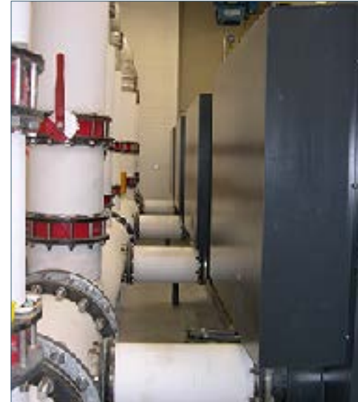
La figura in alto mostra un collettore di grandi dimensioni dotato di isolamento per ridurre lo scambio termico con l'aria di raffreddamento dell'unità.
